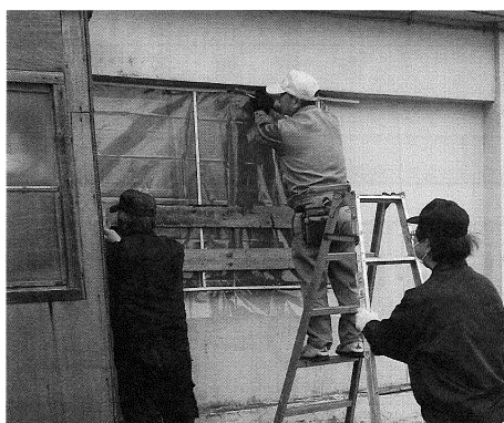
・ビニール貼り
