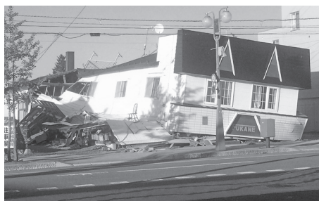
倒壊した家屋
